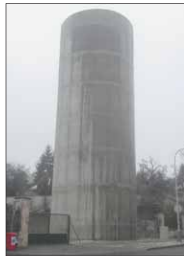
Současná podoba výdechu z Blanky v ulici Nad Octárnou - betonový válec o výšce 24 metrů.
