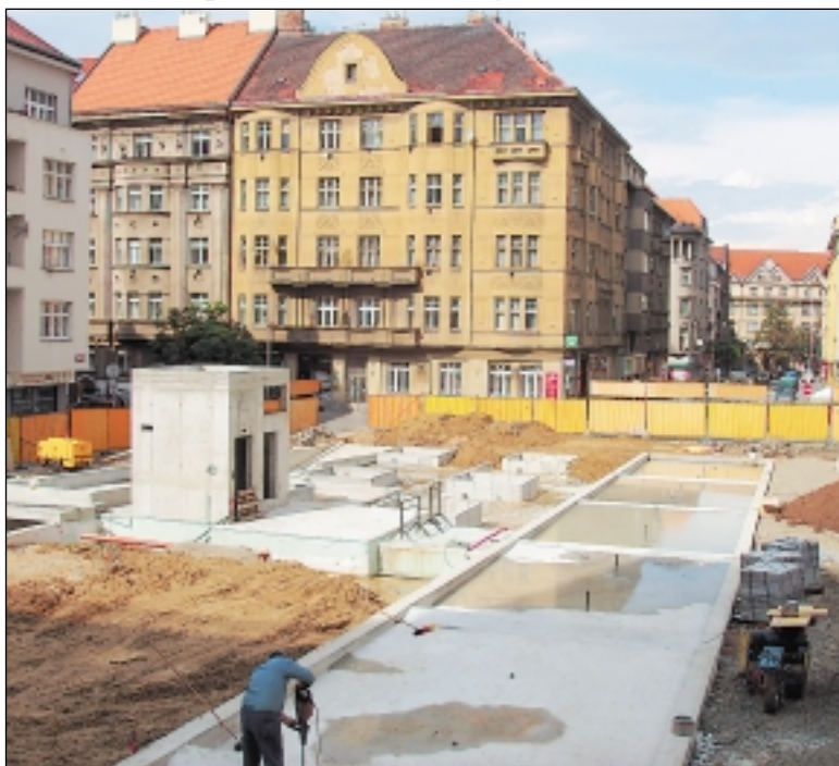
Lidem se již brzy uleví od stavebního ruchu. Podzemní garáže už jsou postavené, dokončuje se vnější podoba náměstí s vodeními kaskádami.
