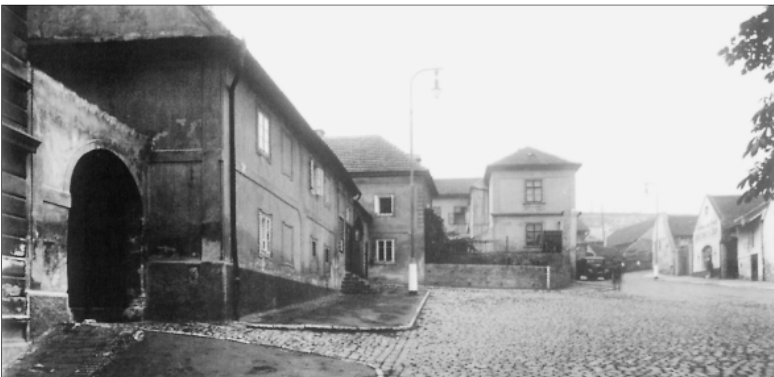
Bývalá břevnovská náves si udržela svůj vesnický ráz s minimem stavebních zásahů až do svého zániku. K tomu došlo v posledním desetiletí socialistické výstavby a jádro Břevnova nahradil soubor panelových domů kolem Sartoriovy a Anastázovy ulice.
