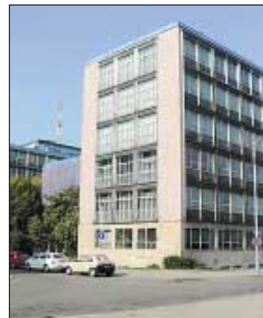
Monoblok dostane postupně novou fasádu a okna.
