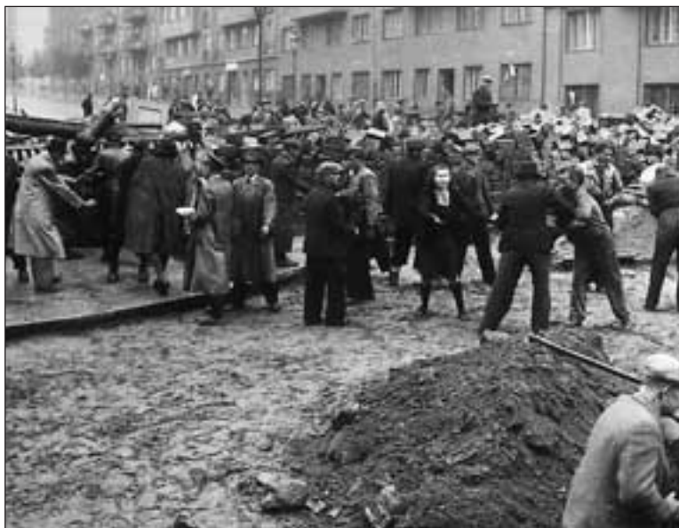
Stavba barikády v Terronské.
