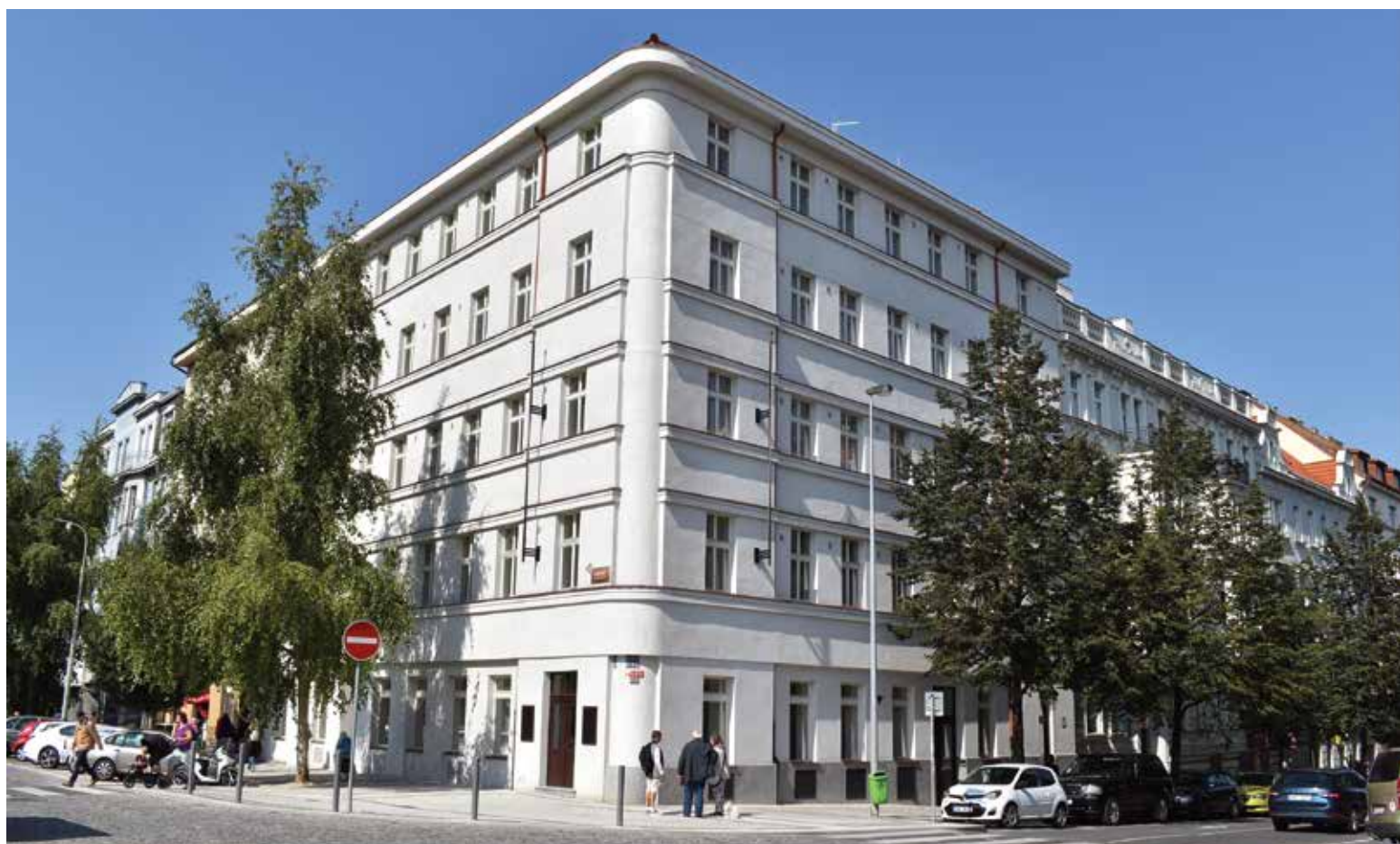
Zrekonstruovaná Dejvická 4. K čemu bude sloužit?
