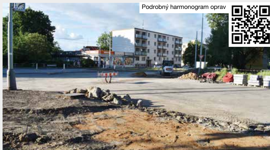
Technická správa komunikací zahájila rekonstrukci křižovatky ulice Na Petřinách a Na Větrníku, která bude nově osazena semaforem. Řidiči tady musejí počítat s omezením do 23. srpna.
