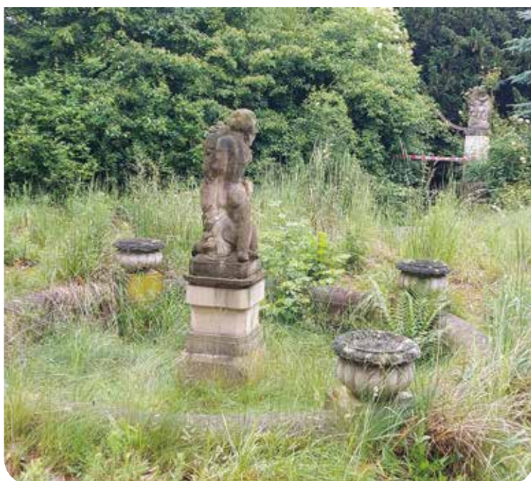
↑ Ještě před měsícem byla kašna zasypaná a zarostlá trávou.
