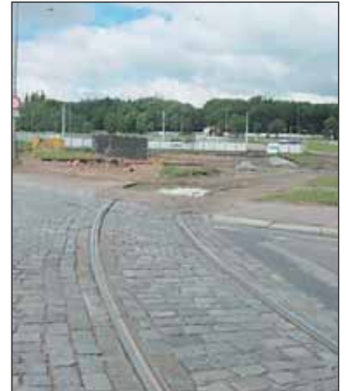
Rekonstrukce trati naváže na současnou opravu tramvajové smyčky na Vypichu, která probíhá v souvislosti s pokračující stavbou metra.
