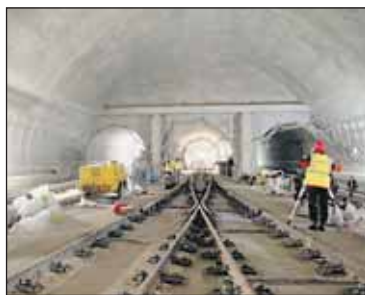
Obratňště kolejí ve stanici Petřiny.
