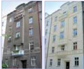
PŘED REKONSTRUKCÍ / PO REKONSTRUKCÍ
