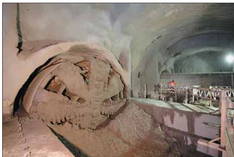
Razící štít při prorážce do stanice.
