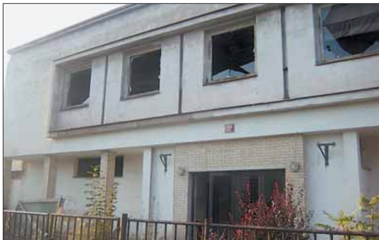
V objektu v Kralupské byla zahájena demolicí.
