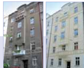
PŘED REKONSTRUKCÍ / PO REKONSTRUKCÍ
