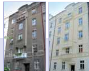
PŘED REKONSTRUKCÍ / PO REKONSTRUKCÍ
