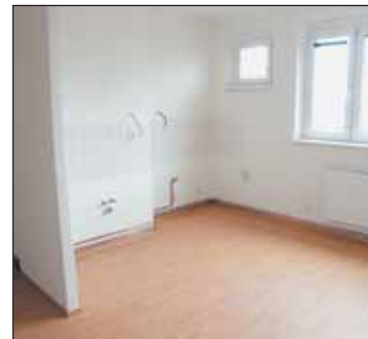
Praha 6 v tempu pokračuje v rekonstrukcích obecních bytů.
