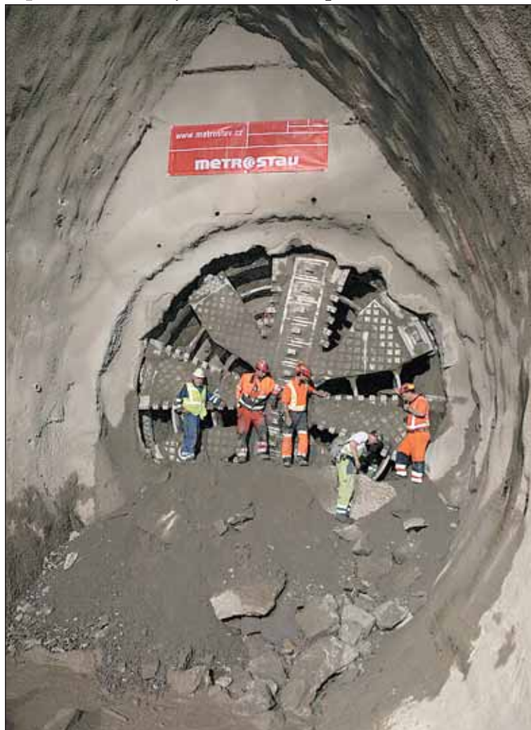
Prorážku posledních metrů s napětím čekali hlavně pracovníci Metrostavu. Více fotografií si lze prohlédnout v informačním středisku prodloužení metra v ulici K Lánu 2 každé úterý od 14 do 18 hodin. Foto: Josef Husák, Metrostav
