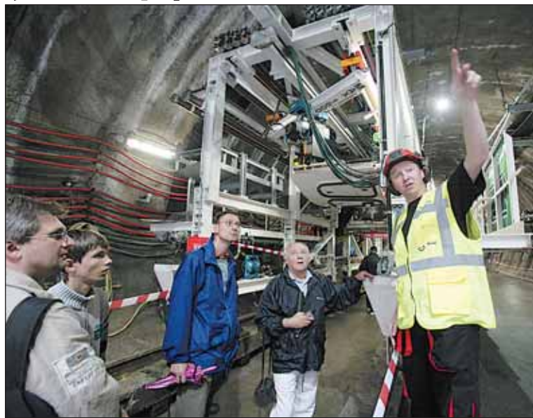
Za razícím štítem zůstává přímo hotový tunel. Vše zařídí stroje, pouze šrouby na spojích ostění musejí upevňovat lidé.
