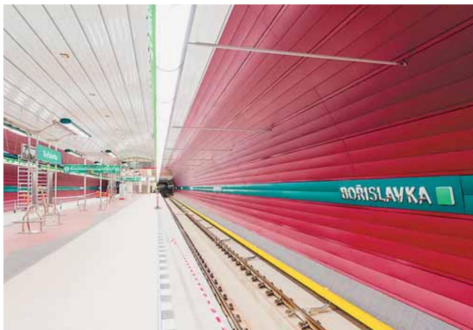
První novou stanicí ve směru od centra je jednolodní Bořislavka, leží 26,7 metrů pod úrovní Evropské ulice.
