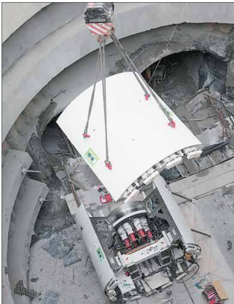
Montáž štítu s číslem 609. Historicky první štít v Čechách se pomalu dává dohromady na Vypichu. Razit začne na konci března. Foto: Josef Husák, Metrostav, a.s.
