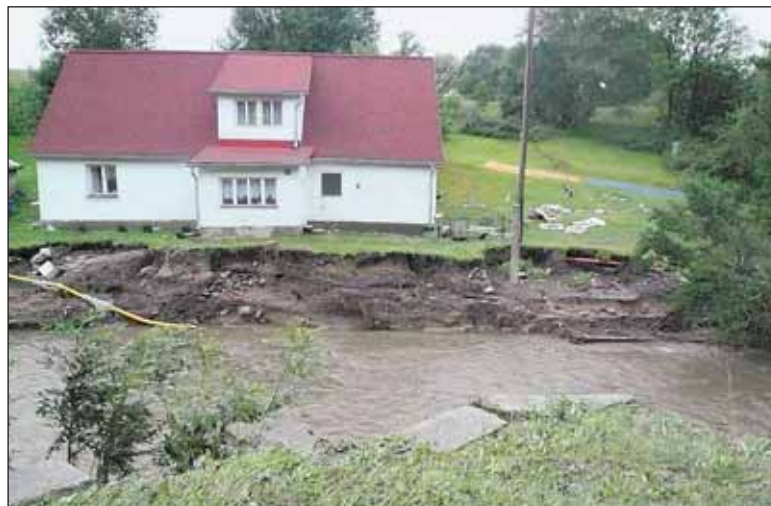
Praha 6 poslala pomoc do Heřmanic. Pomoc v nouzi jí není cizí. V minulosti takto pomáhala Šenovu u Nového Jičína, Veselí nad Lužnicí, Tatrám, zaplavenému Karlínu. Velké zkušenosti má se záplavami v Dolním Sedlci v roce 2002, kdy ještě patřil k Suchdolu.
