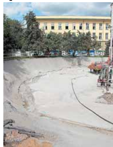
Propadlý tunel v zahradě ministerstva je částečně zalitý betonem. Práce zatím stojí.
