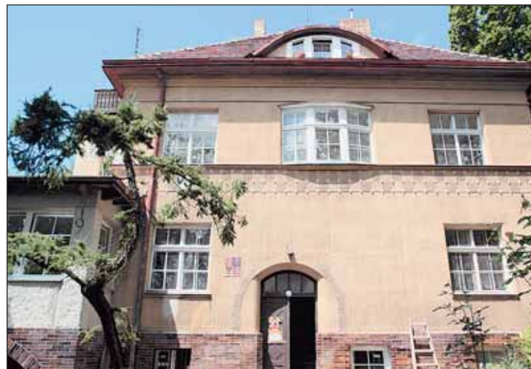
Díky rekonstrukci v Půlkruhové ulici vila prokoukla a objeveny se i detaily na fasádě. Kromě vedení školy v ní jsou umístěny nové hudební třídy.
