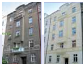
PŘED REKONSTRUKCÍ / PO REKONSTRUKCÍ
