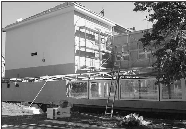
K rekonstruované školní budově ZŠ Interbrigády byla postavena nová propojovací chodba do jídelny.
