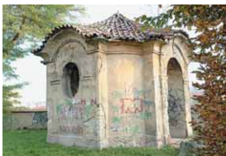
Kaple Josefa v areálu kláštera je jedním z objektů, které by měly projít rekonstrukcí. (více na str. 7)
