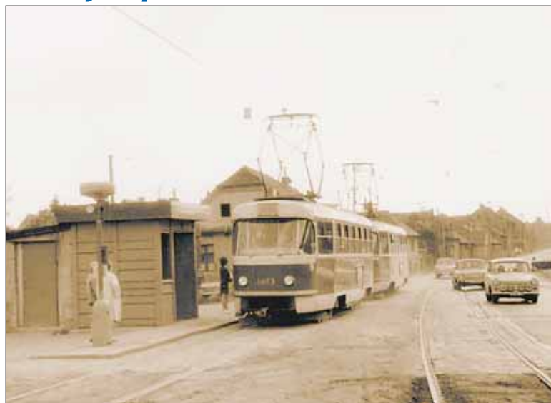
Informace poskytl Ing. Jan Šurovský, Ph.D., vedoucí jednotky Dopravní cesta Tramvaje. Foto: Ivo Mahel (18. května 1974).
