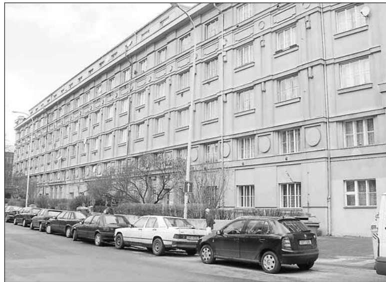
Opravy se letos dočká blok domů v Rooseveltově ulici.
